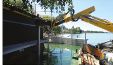
Bei Sanierungen von Ufermauern und anderen unterspülten Bauwerken steht das Team des Unternehmens TAF Taucharbeiten AG mit Gewebeschalungen oder Gewebecontainern im Einsatz. Sie werden mit einem speziellen Unterwasser-Beton «geimpft». Die Gewebe bestehen aus Chemie-Kunstfasern von hoher Reissfestigkeit. Für Beton undurchlässig, schützen sie diesen während der Aushärtungsphase vor Auswaschungen.
